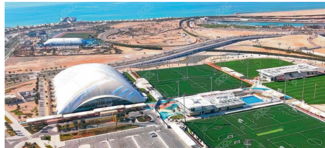
Traglufthalle mit Klimaanlage und Panoramafenstern, gebaut 2023 auf der Insel Al Hudayriyat, Abu Dhabi. Ausgestattet mit dem DUOL ECO Ultra Membransystem sorgt sie für ein stabiles Innenklima (+25°C) bei Außentemperaturen von bis zu +55°C. Dahinter steht unsere erste Traglufthalle an diesem Standort (2020), was die hohe Kundenzufriedenheit und das Vertrauen in DUOL widerspiegelt.
